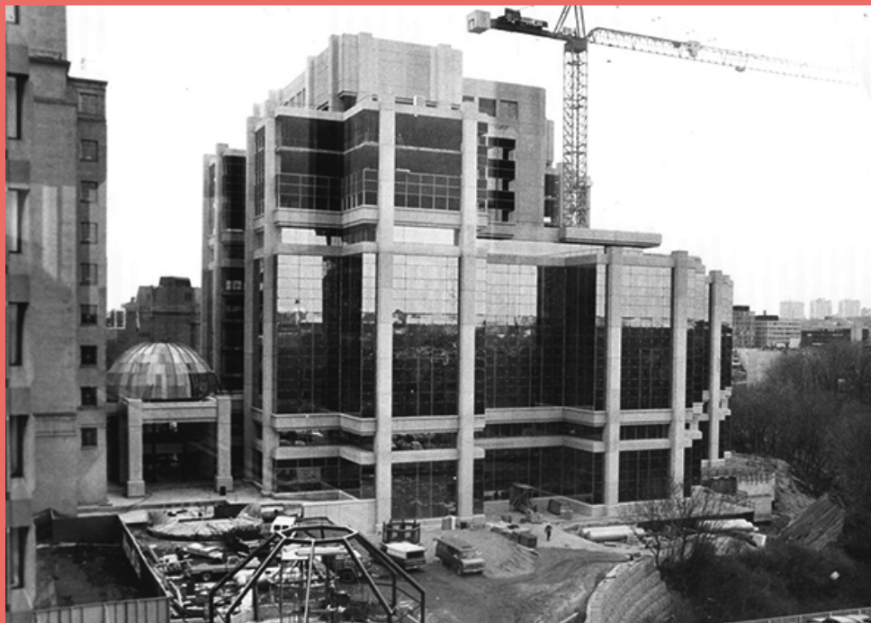
建設中の様子
